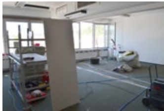
Noch wird intensiv renoviert, doch am 1.9.2015 soll die Schlüsselübergabe erfolgen.
