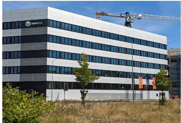
Außenansicht des Neubaus (© HSPV NRW)
