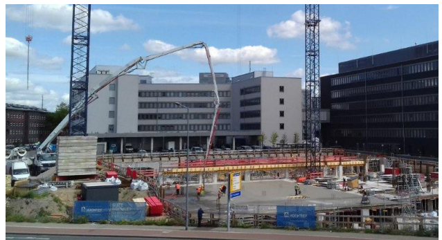
Baustellenbild vom 22. Juli 2020 (Foto: Hochtief)
