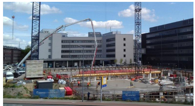
Baustellenbild vom 22. Juli 2020 (Foto: Hochtief)
