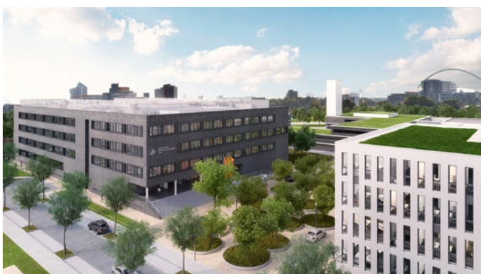
Am Deutzer Feld entsteht momentan ein neues Gebäude der Abteilung Köln.
