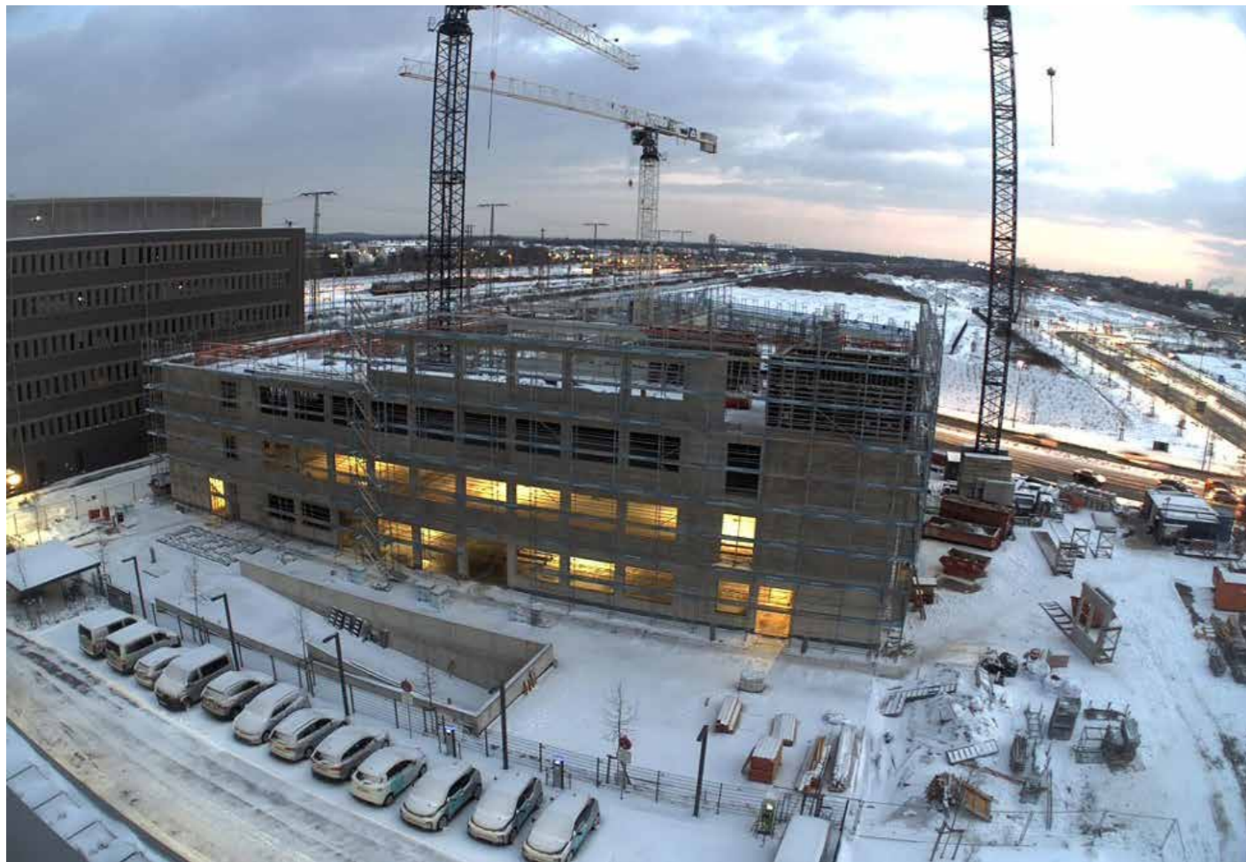
Großes Bild Rohbau der Abteilung Duisburg (Bild: Aurelis 17, Objektgesellschaft GmbH & Co. KG)
