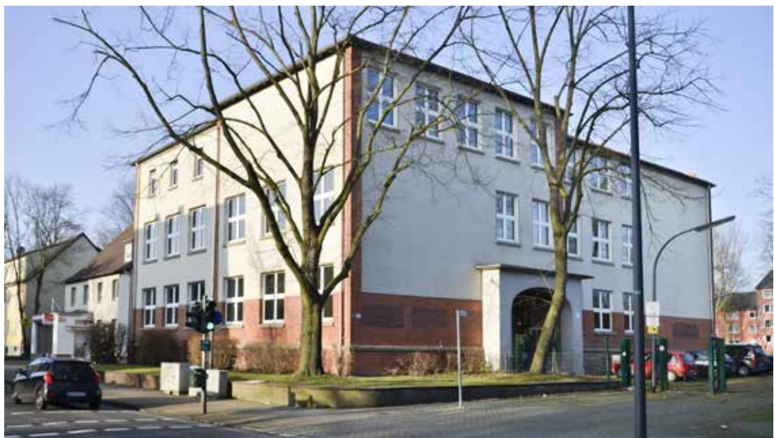
Die ehemalige Görresschule in Herne. (Fotos: Thomas Schmidt, Stadt Herne)
