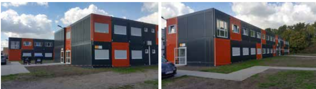
Neue Containerbauten für die Außenstelle Mülheim an der Ruhr. (Fotos: FHöV NRW)
