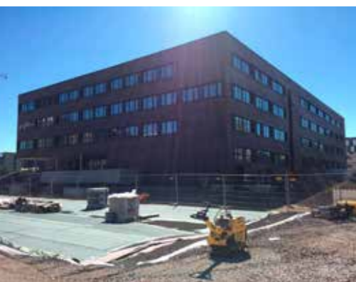
Bauarbeiten am Neubau in Köln.
